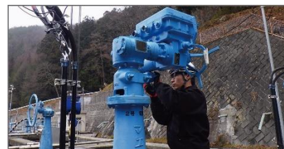
浄水場や下水処理場の 点検・修繕
