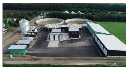
バイオガスプラント
