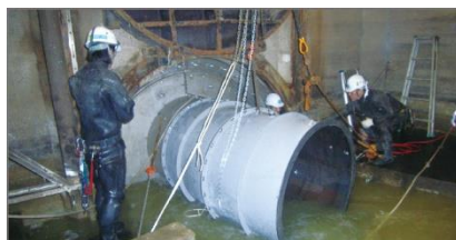
浄水場や下水処理場の 建設・更新
