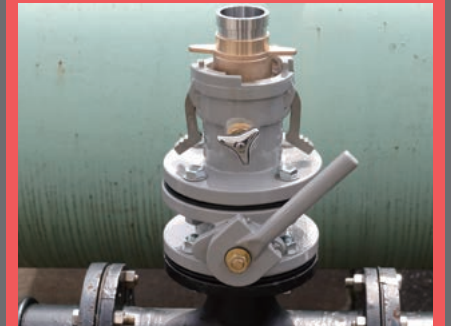
カムロック後、 町野式口金取り付け完了
