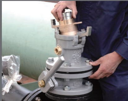
町野式口金ねじ込み、 排水弁取り付け
