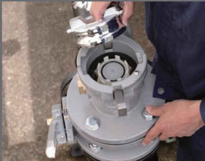
弁ふた・内部部品を取り外し、 パッキン挿入
