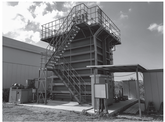
中川水循環センター内に建設された実験設備全体
