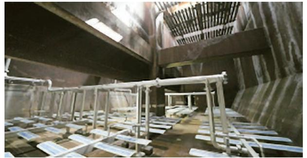
図-5 深槽式反応タンク底部に設置した散気装置
