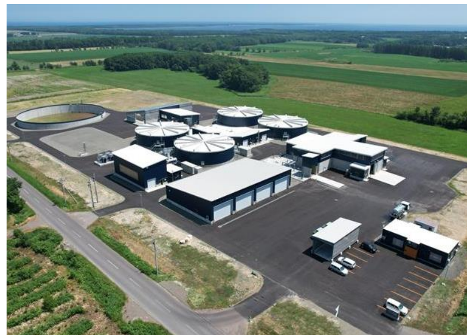
湧別バイオガスプラント完成写真
