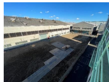
R6.11月 撤去工事完了
