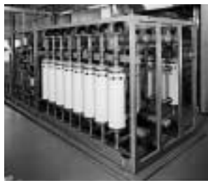
膜ろ過浄水装置
