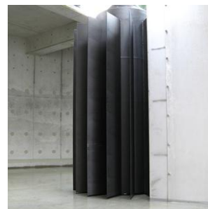
縦軸水流発生装置
