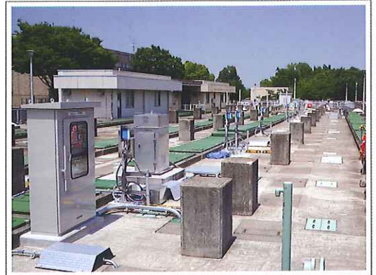
③ 水質センサーを装備した無終端水路型反応タンク
